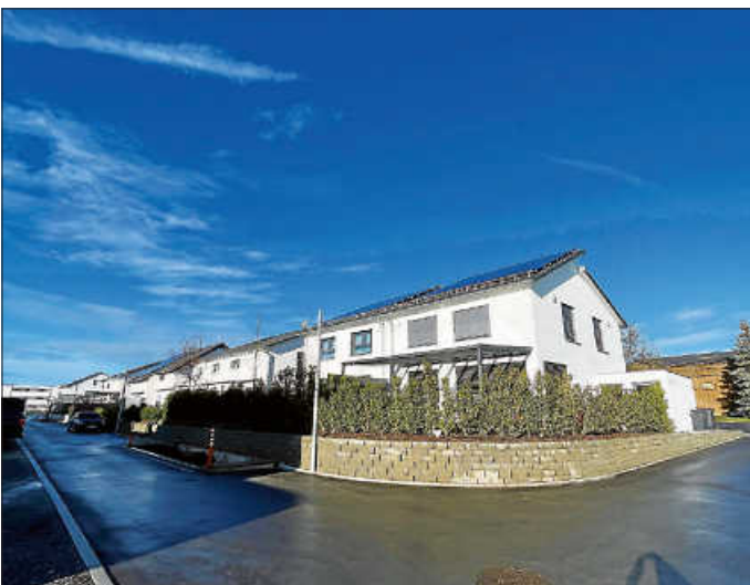
Das Baugebiet „Nördlich Schelmenäcker / Pfuhlweg“, hier die Neubauten am Pfuhlweg ...
