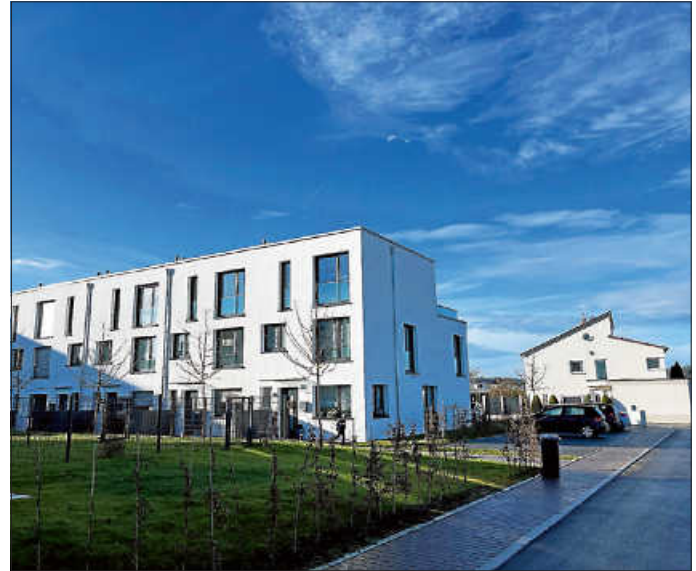
... hier die Ansicht der Neubauten Ecke Schelmenäckerstraße / Johann-Besserer-Straße.
