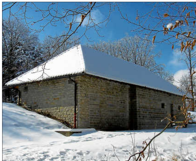
Das oberirdische Gebäude des Wasserhochbehälters Stockhau mit den technischen Anlagen, u.a. mit der Druckerhöhungsanlage für Perouse. Umgeben von kühlender Erde können hier bis zu 2.500 m 3 Trinkwasser gespeichert und dank der Höhenlage von 489,80 m ü.NN. mit dem natürlichen Höhenunterschied, ohne pumpen zu müssen, in das Ortsnetz von Rutesheim fließen.
