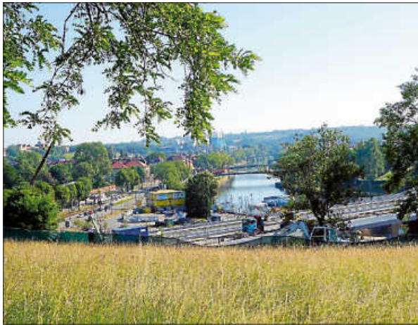
Die neue Bahnbrücke über den Neckar
