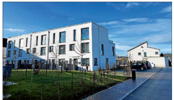
... hier die Ansicht der Neubauten Ecke Schelmenäckerstraße / Johann-Besserer-Straße.
