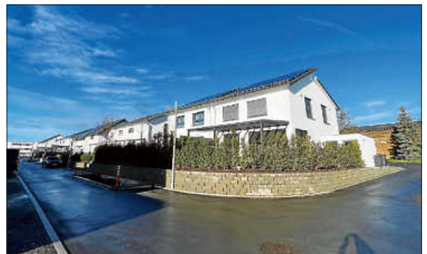
Das Baugebiet „Nördlich Schelmenäcker / Pfuhlweg“, hier die Neubauten am Pfuhlweg ...
