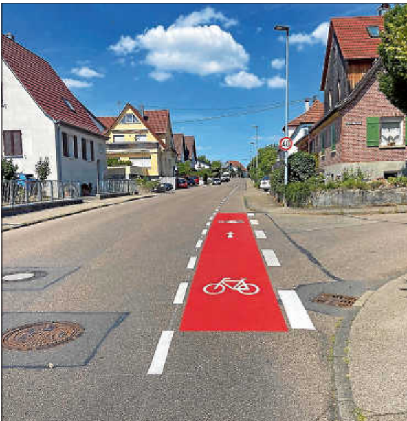
Neu angelegt wurde ein Radfahrerschutzstreifen in der Flachter Straße
