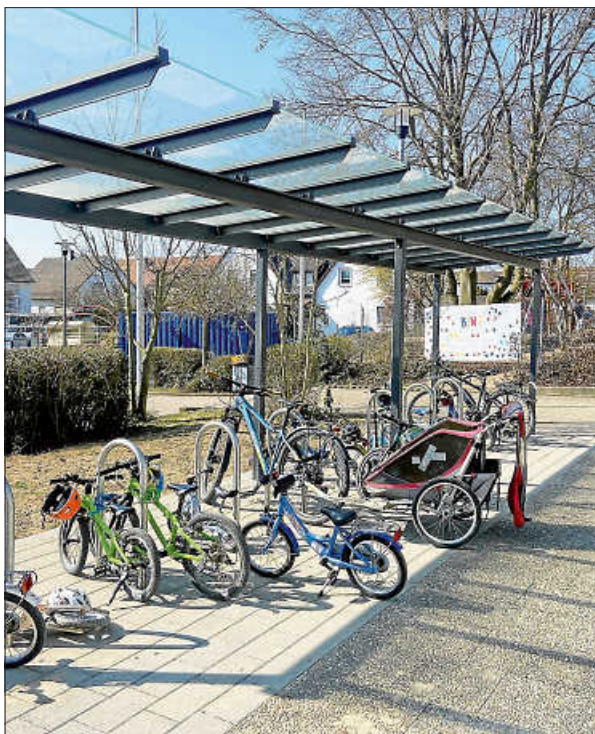
Bei der Gemeindehalle Perouse wurde eine überdachte Radabstellanlage neu gebaut.
